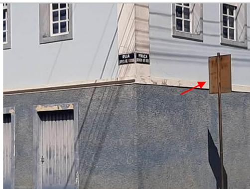
**Foto 8.** Placa de logradouro público e placa de trânsito com oxidação significativa.
