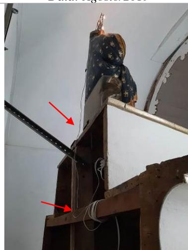
**Foto 12.** Fiação exposta e vista interna da base em madeira
