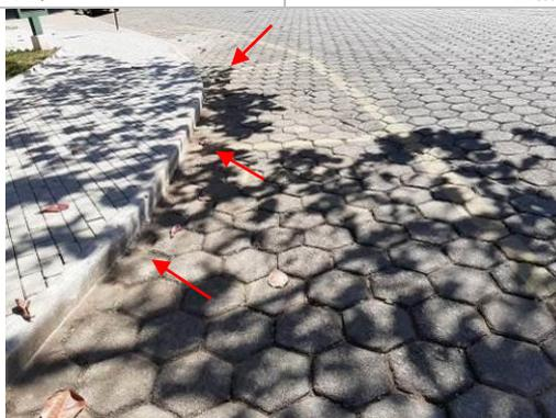
**Foto 16.** Acúmulo de terra na sarjeta indicando falhas no sistema de escoamento de águas pluviais.
